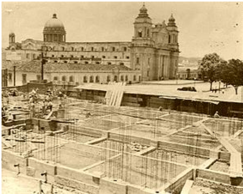
Construcción del segundo nivel del Palacio Nacional, al fondo la majestuosa Catedral Metropolitana. Año 1941.
