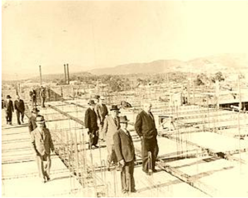
Supervisión de Ingenieros en el segundo nivel del Palacio Nacional. Foto: Rafael Morales Sánchez.
