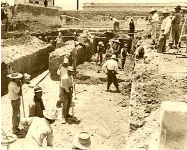
Trabajos de cimentación del Palacio Nacional en el año 1939.
