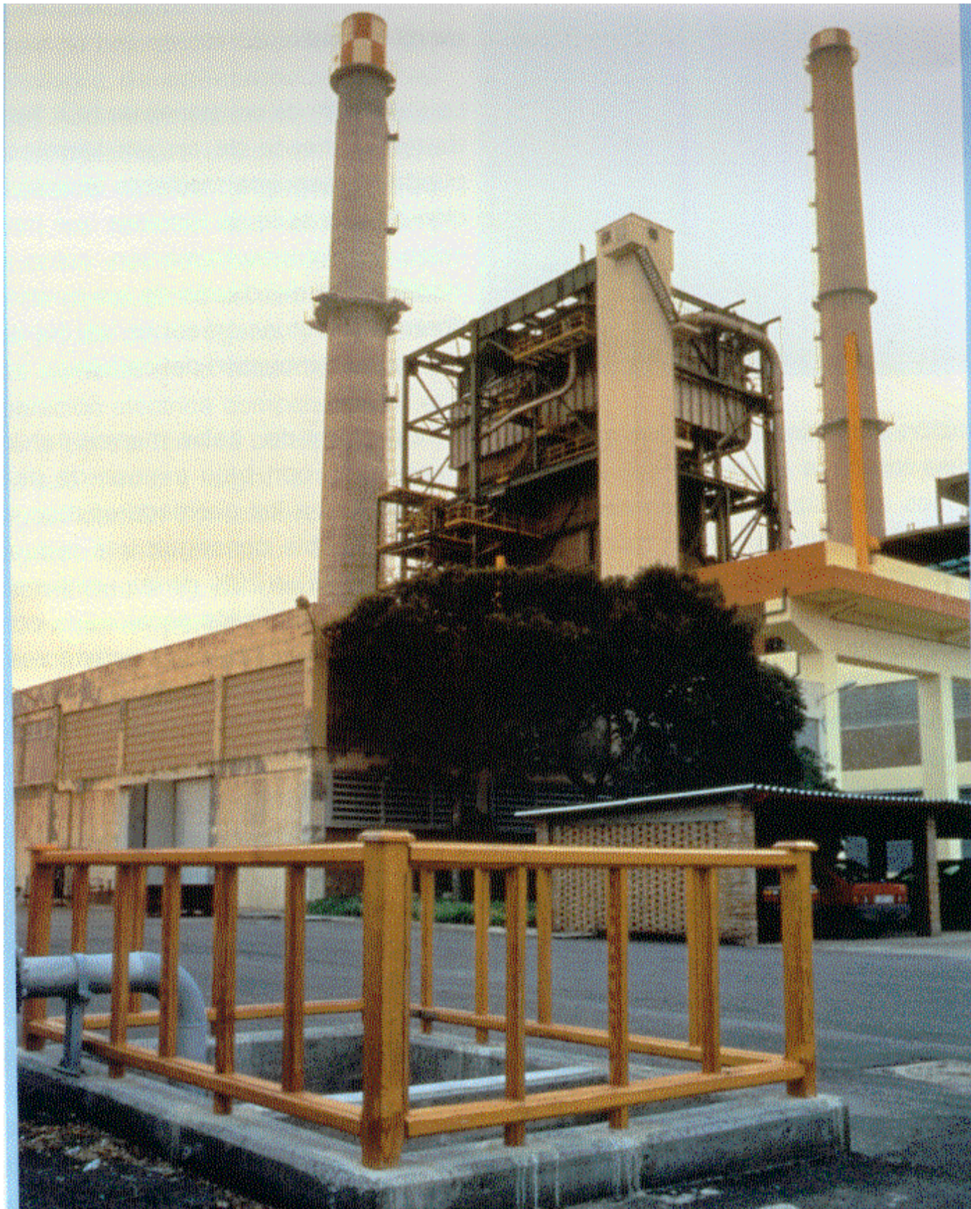
Pozo de recogida de aguas en la central térmica de Besós
