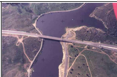
Fotografía aérea aplicada a la supervisión e inspección de obras de ingeniería.
